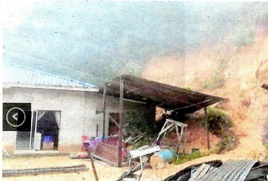
DAPUR sebuah rumah yang rosak teruk selepas dihempap tanah runtuh di Kampung Pelangai Hilir, Kuala Pilah kelmarin.
